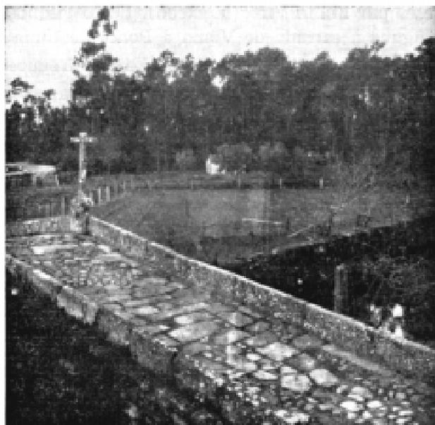
**Pormenor da ponte de Tourim, freguesia de Amonde. Ponte de um só arco, que mede de abertura 10,00 m. e de altura, 5,80 m. Largura total da ponte: 4,00m. Comprimento da parte ladeada: 36 metros.**
